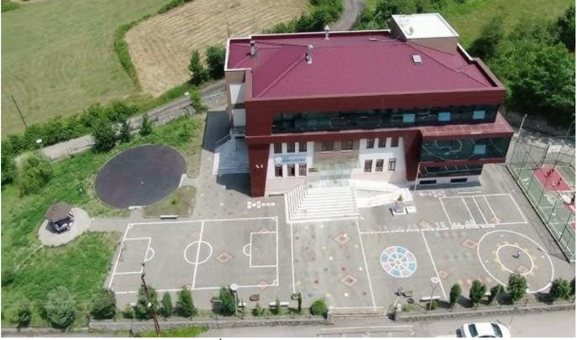
Şekil 3. Ağdacı İlkokulu Müdürlüğü Hizmet Binası
